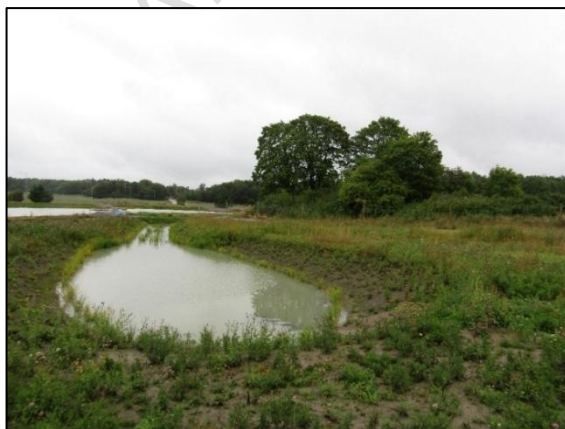
Figur 25. Dagvattendamm med permanent volym samt öppen regleringsvolym.
