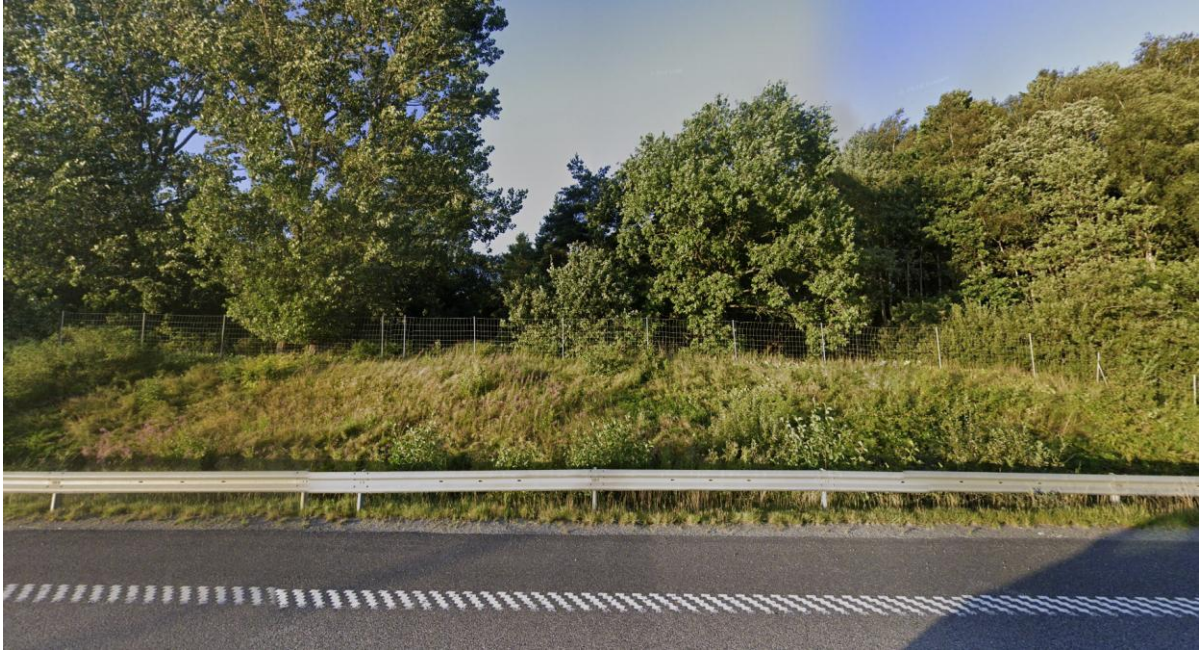
Figur 12. Bild där fördelaktig topografi och dike mellan väg E6 och planområdet framgår. Vy från väg mot planområdet [21].
