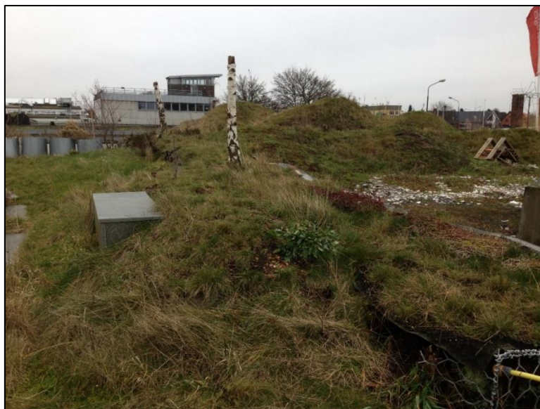
Figur 15. Intensivt grönt tak med kraftigt varierande substratdjup (Foto: Johan Emanuelsson).
