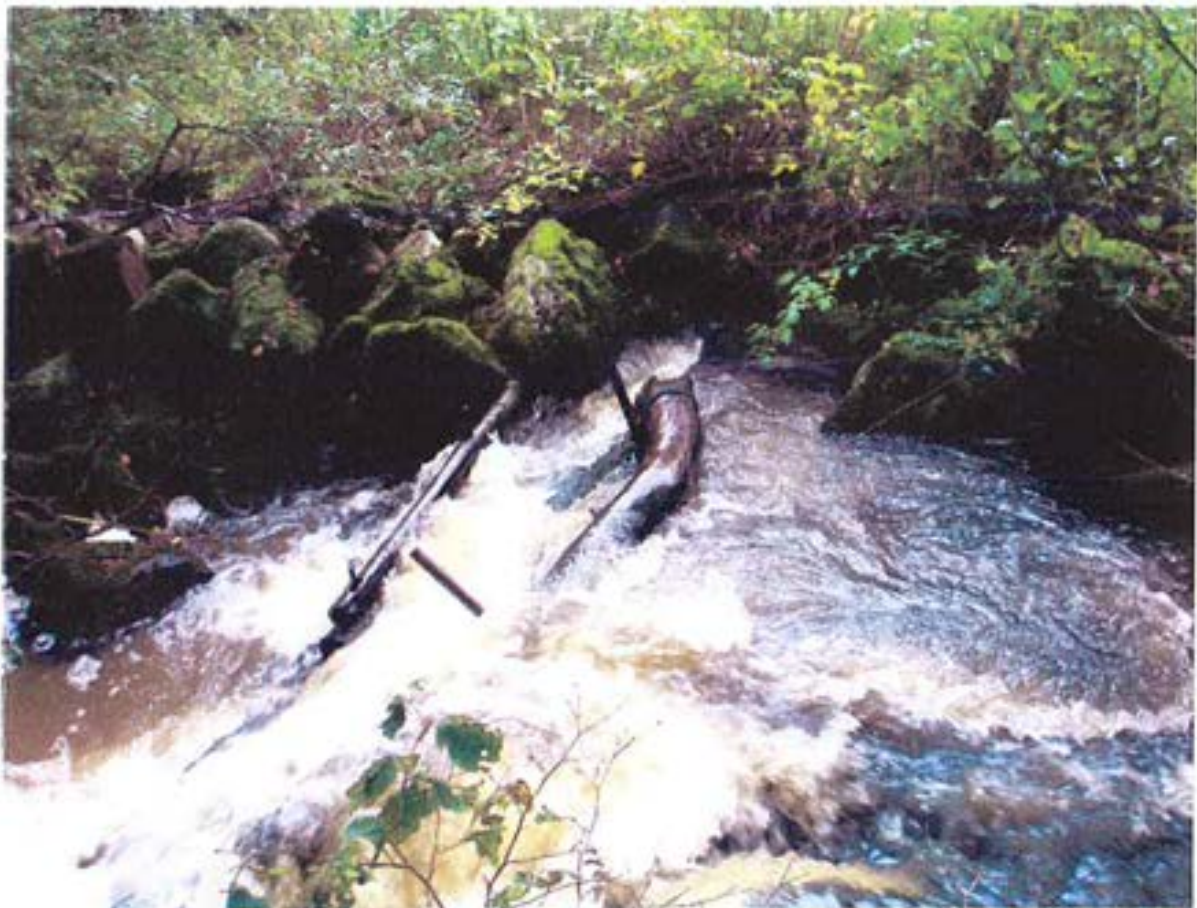
Nedre fiskvägen i Kollerödsbäcken (observera de böjda järnstolparna).
