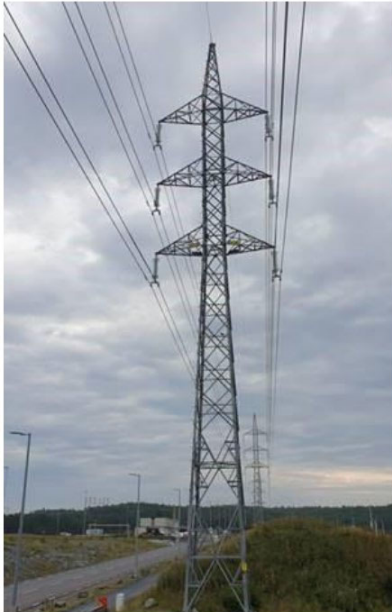
Figur 9. Bilden visar exempel på den typ av stolpar som är aktuella för ny dubbel 130 kV-ledning.
