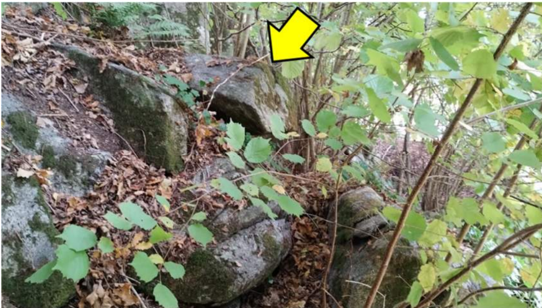
Figur 18. Foto mot nord-nordost. Uthängande block i rasbrant.
