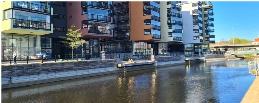
Kombinerat högvattenskydd och mötesplatser på kajen. Gamlestaden, Göteborg
