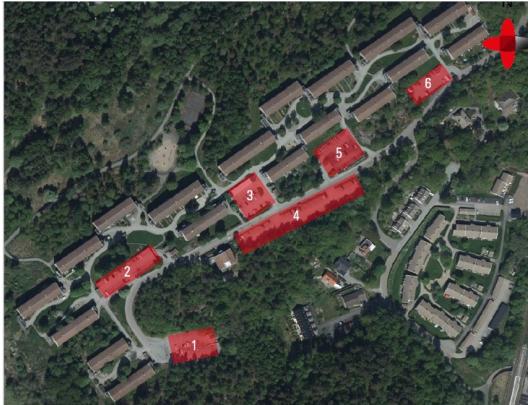
Figur 4. Parkeringsanläggningar, Sigma Civil.
