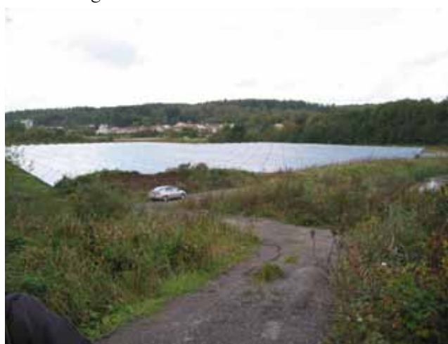
Intill Munkegärdecentralen ligger en 10 000 kvadratmeter stor solfångaranläggning som bidrar med solvärme.
