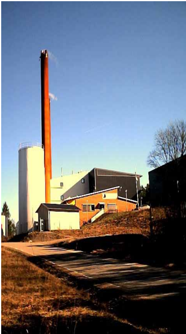
Munkegärdecentralen i Kungälv som levererar 100 % förnyelsebar energi och sedan våren 2006 även producerar el.
